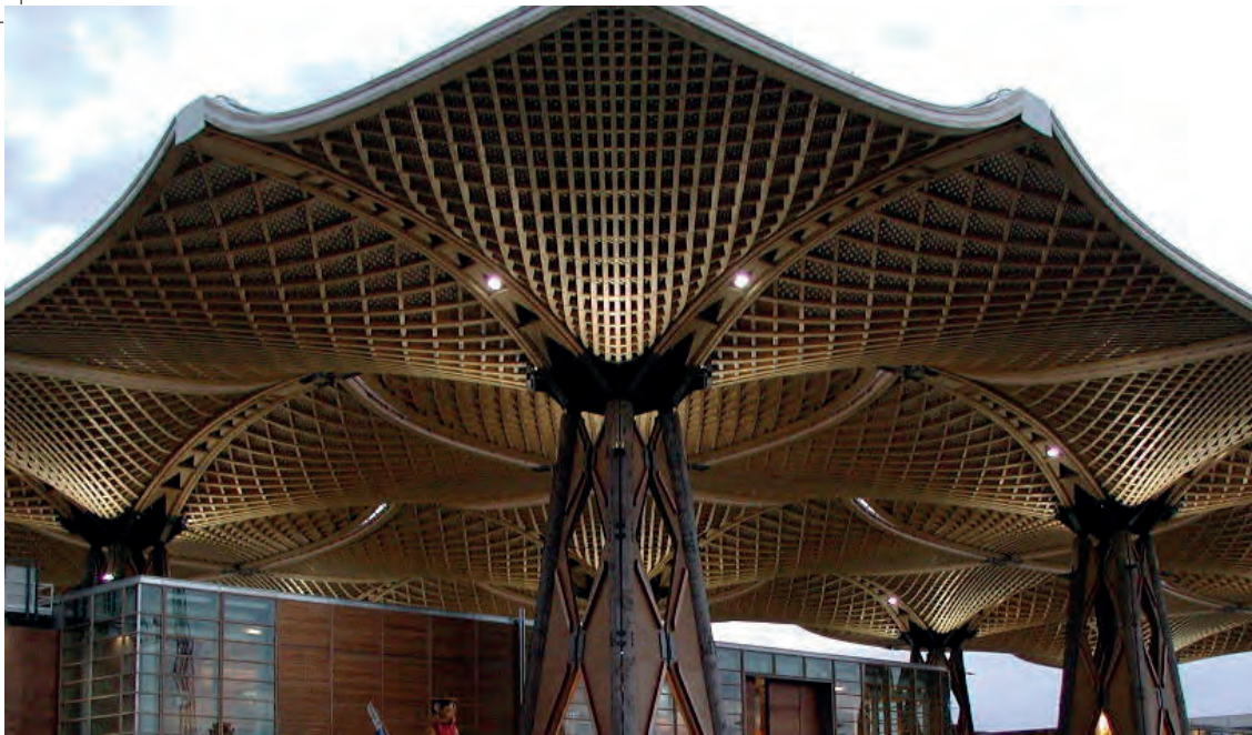
© „Expo 2000 Dach Holzkonstruktion“ Erwin Müller CC BY-SA 3.0 via Wikimedia Commons
